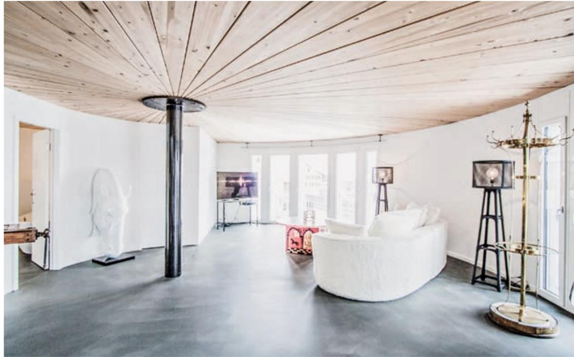
Die Holzdecke läuft sternförmig auf die einzige tragende Stütze im Raum zu.
