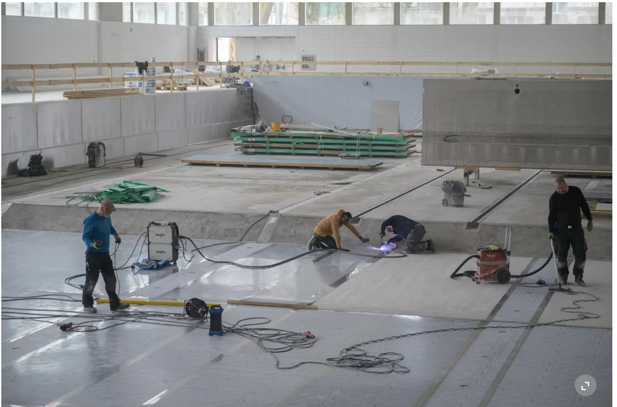
Am Boden des 50-Meter-Beckens werden Chromstahlplatten verschweisst. Ein Teil des Beckens wurde für die Synchronschwimmerinnen und Synchronschwimmer 50 Zentimeter tiefer gebaut.
