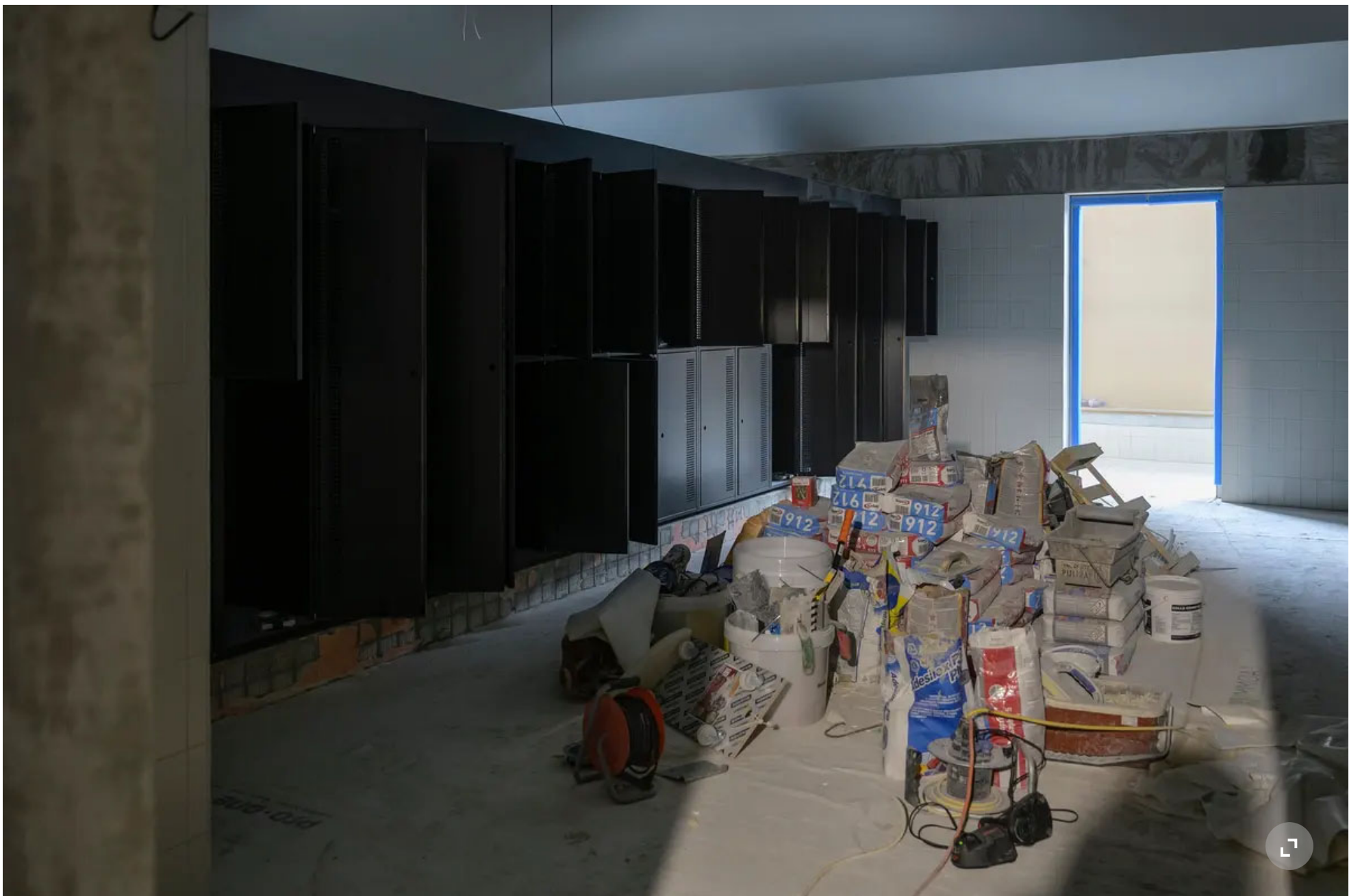
Insgesamt werden neun Garderoben für rund 500 Schwimmerinnen und Schwimmer gebaut. Foto: Franziska Rothenbühler
